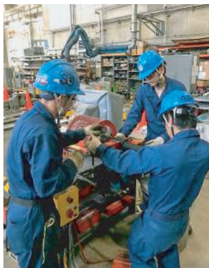
Making of flexible hose フレキシブルホースの作製
