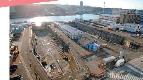
明治から昭和にかけて建造されたドライドックなど、貴重な近代化遺産が残されています。
