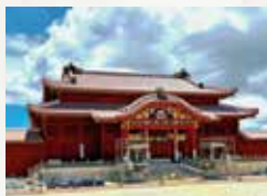
完成間近な正殿
